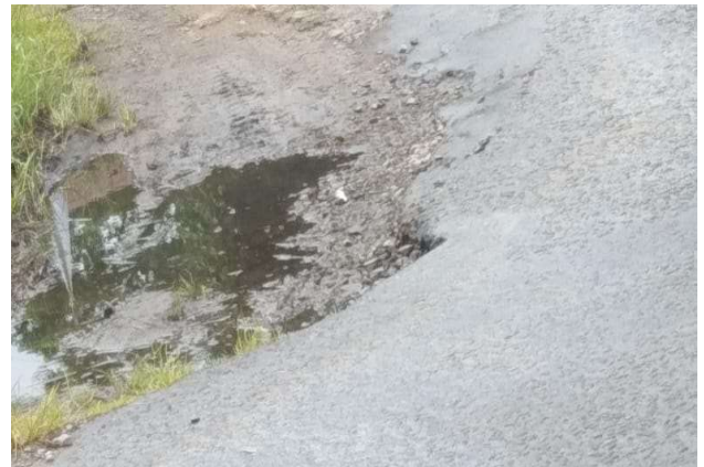
Gambar 4.3. Kerusakan jalan titik 2
