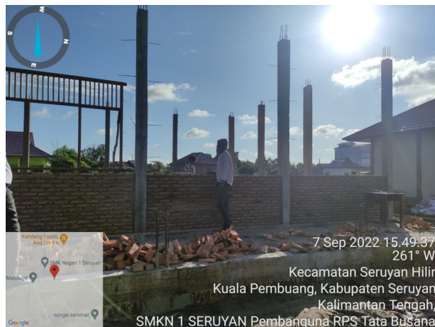
Gambar 3. Pekerjaan Pas Bata, Kusen Pintu dan Jendela
