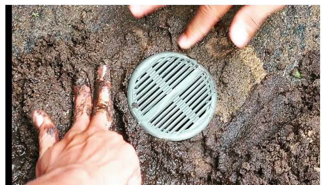
Gambar 3. Foto pembuatan timbunan dan merapikan pondasi lubang resapan biopori.
