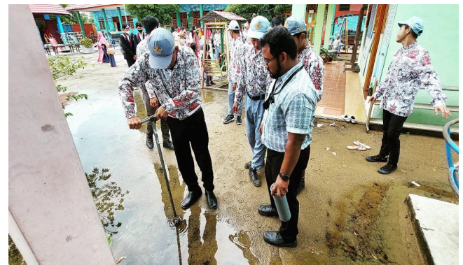
Gambar 2. Foto pengeboran dan pengaplikasi 4 lubang resapan biopori.
